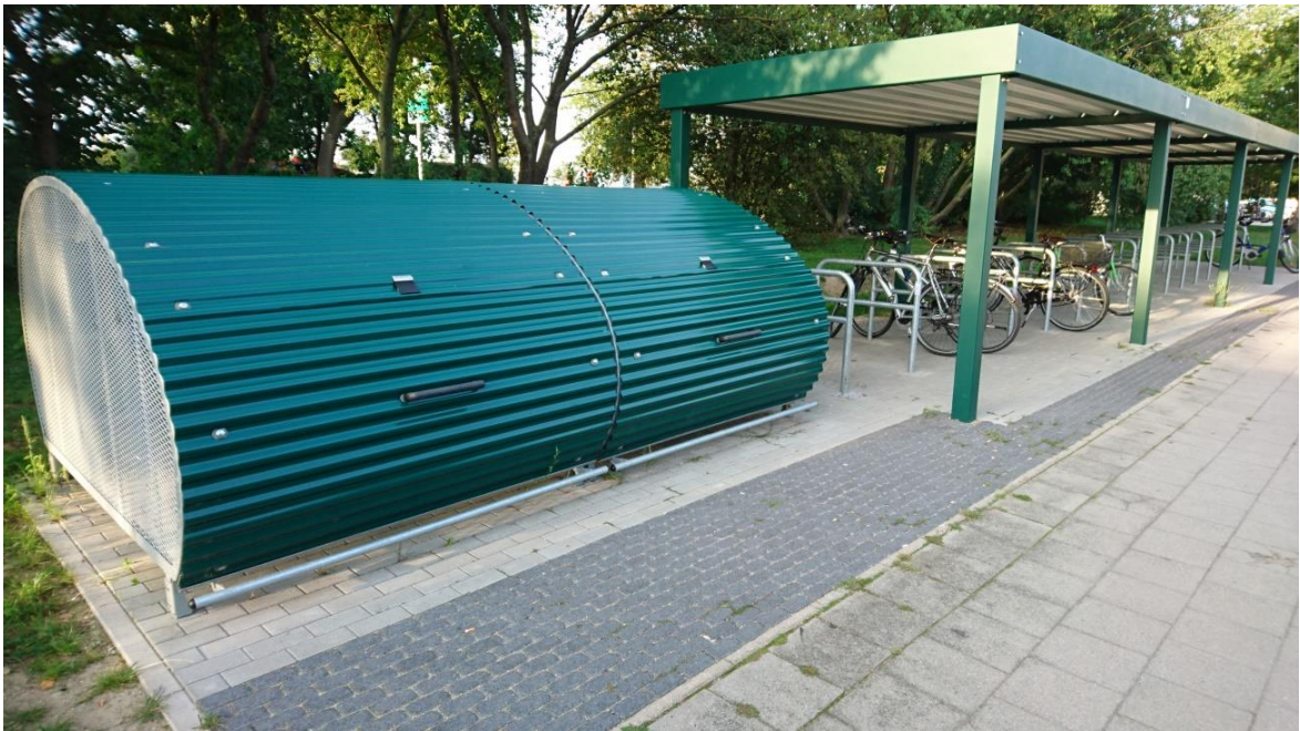
Abbildung 30: Abschließbare Fahrradgarage an der Haltestelle „Hohe Düne Fähre“
