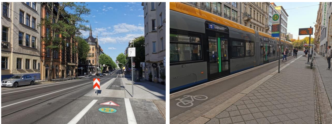
Abbildung 84: Haltestellenkap mit angehobener Radfahrbahn (linkes Bild; Beispiel: Kassel; rechtes Bild; Beispiel: Leipzig)
