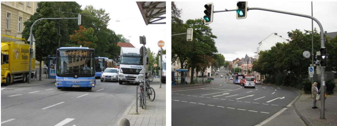
Abbildung 88: signalgesicherter Fahrstreifenwechsel vor Knotenpunkt zur Absicherung der störungsfreien Fahrt auf die Linksabbiegerspur (Beispiele: München (links) und Kassel (rechts))
