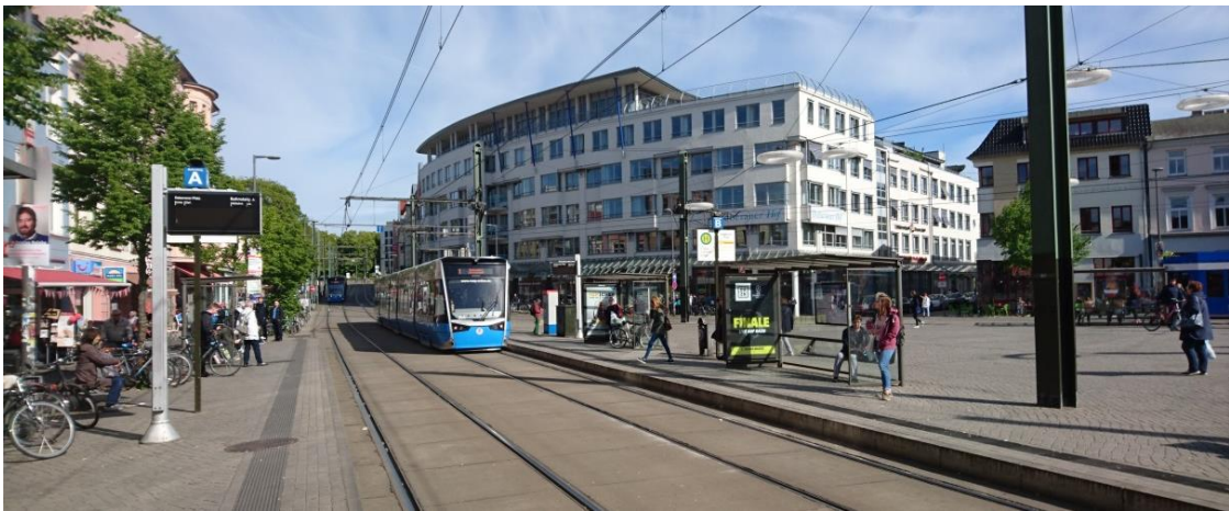
Abbildung 45: Der Doberaner Platz wurde im Jahr 2006 umfangreich umgebaut. (Umbau mit Verkehrsberuhigung des Platzes durch die Herausnahme des MIV sowie mit Modernisierung von vier Straßenbahnhaltestellen und einer Bushaltestelle)
