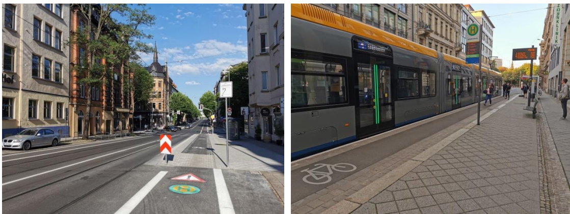
Abbildung 84: Haltestellenkap mit angehobener Radfahrbahn (linkes Bild; Beispiel: Kassel; (rechtes Bild; Beispiel: Leipzig)
