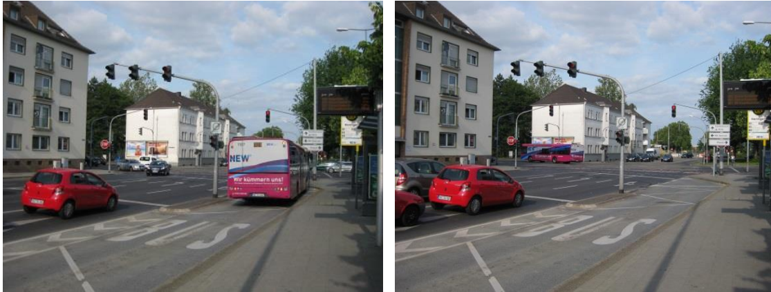
Abbildung 86: Busschleuse an einem Knotenpunkt mit Haltestelle für linksabbiegenden Bus (Beispiel: Mönchengladbach)
