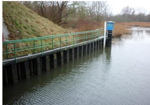
Abbildung 7: Leitwerke am Unterhaupt, Ansicht
