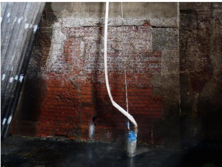
Abbildung 16: Mauerwerk im Unterhaupt mit wasserführendem Riss
