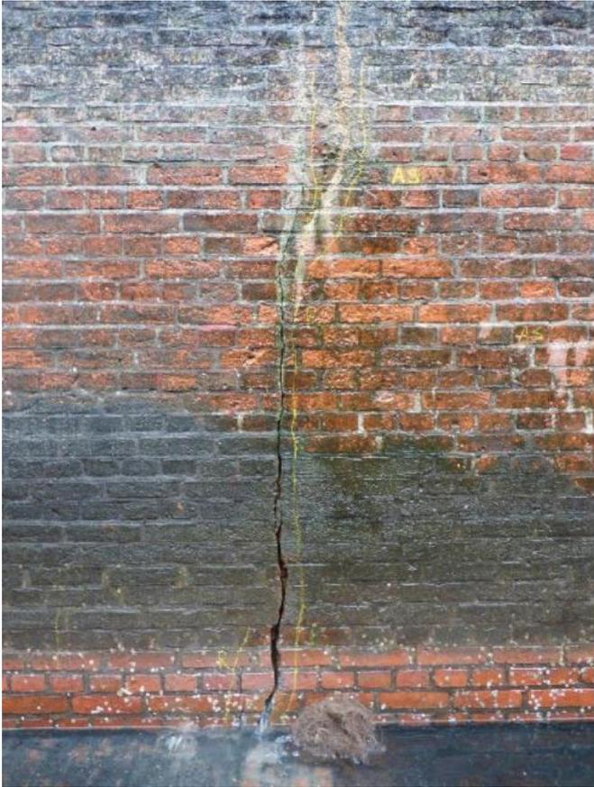
Abbildung 11: Wasserführender Vertikalriss
