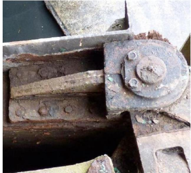
Abbildung 18: Korrodierte Halslager der Fluttore
