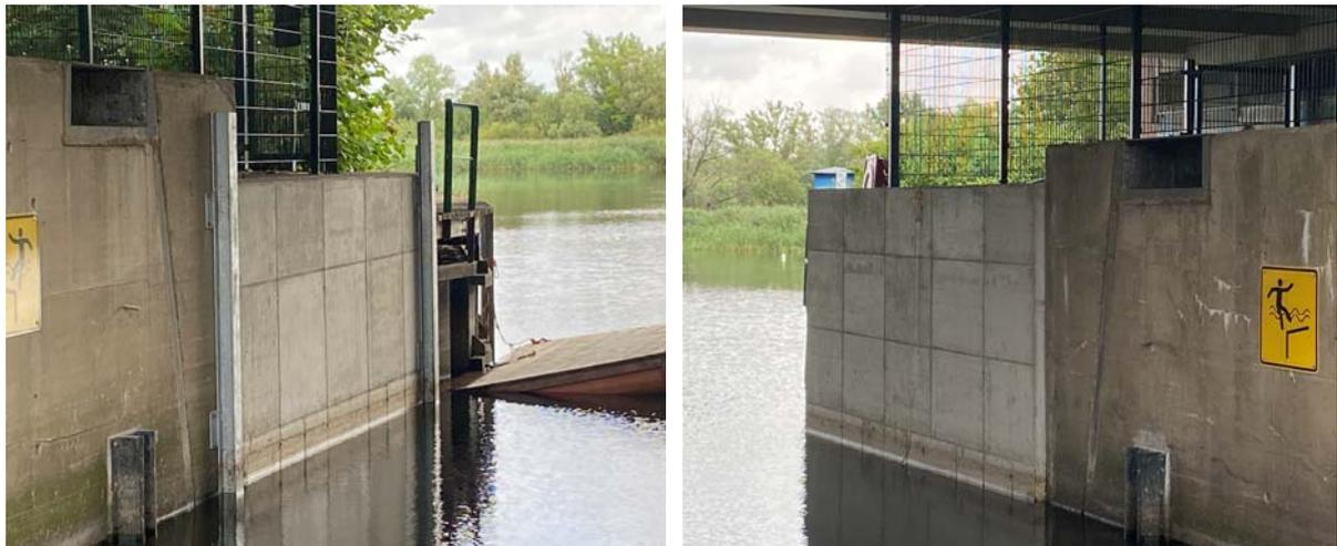
Abbildung 42: Sanierte Kammerwände Oberhaupt (Juli 2021)
