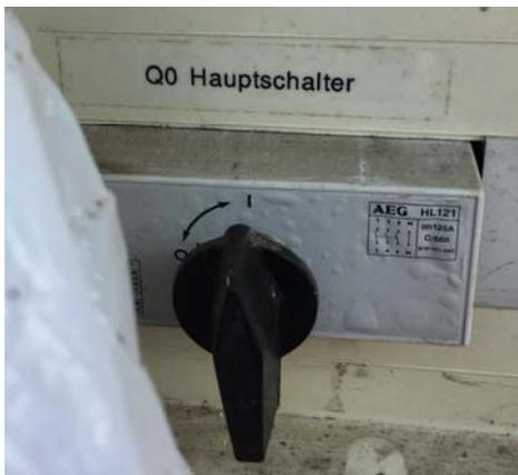
Abbildung 33: Hauptschalter Hausanschluss
