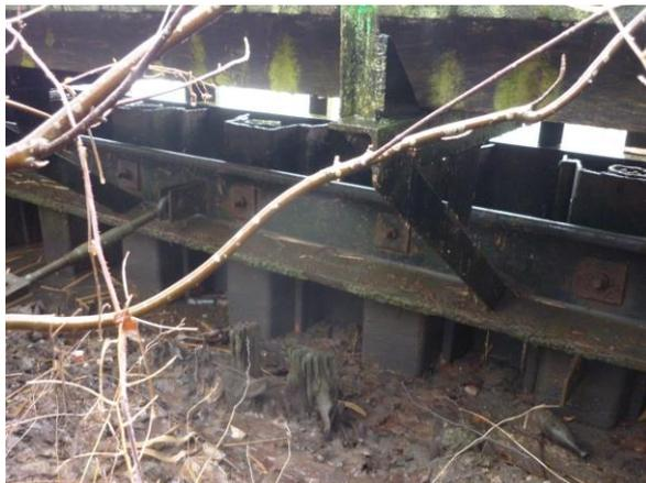
Abbildung 6: Leitwerke am Unterhaupt, Rückansicht
