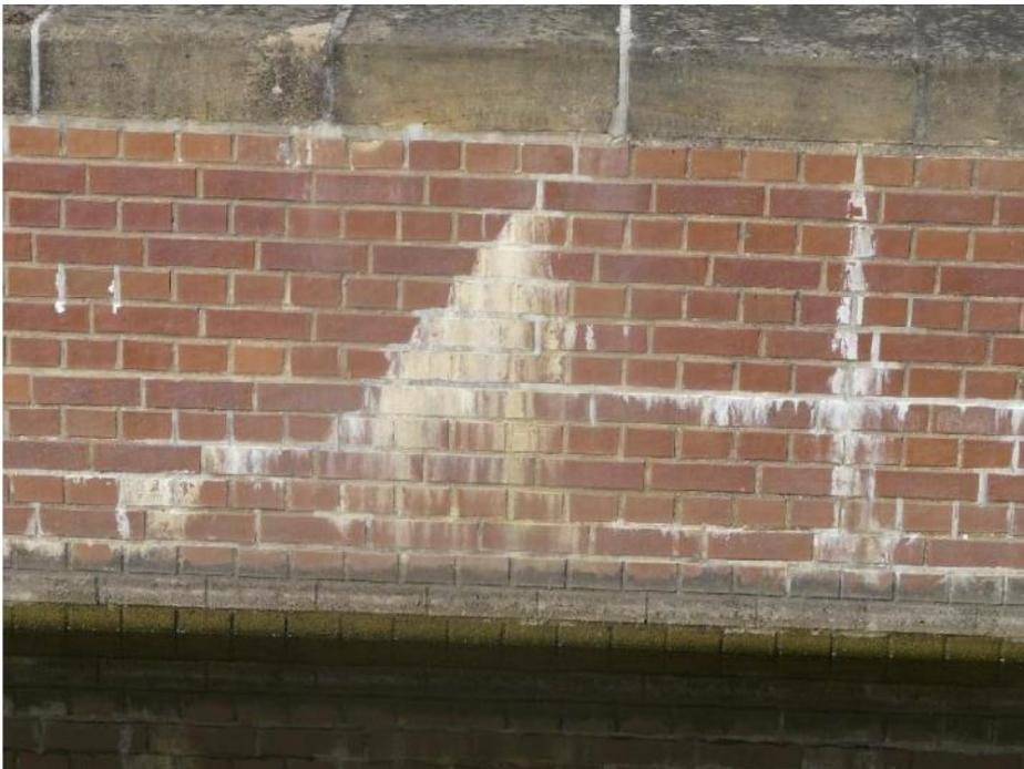
Abbildung 10: Aussinterungen an Kammerwänden
