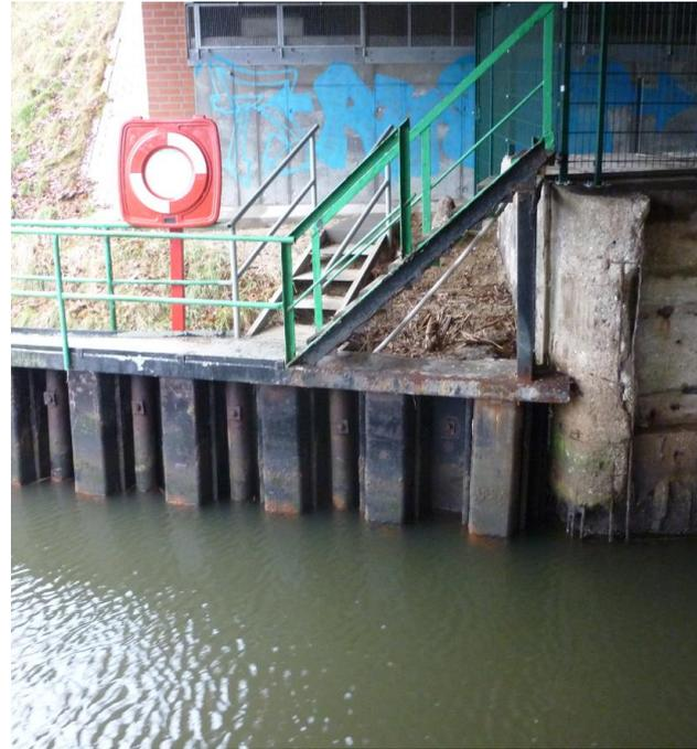
Abbildung 5: Unterhaupt - eingebaute Flügelwände
