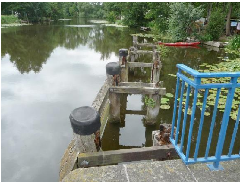
Abbildung 19: Ehemaliges Leitwerk am Oberhaupt
