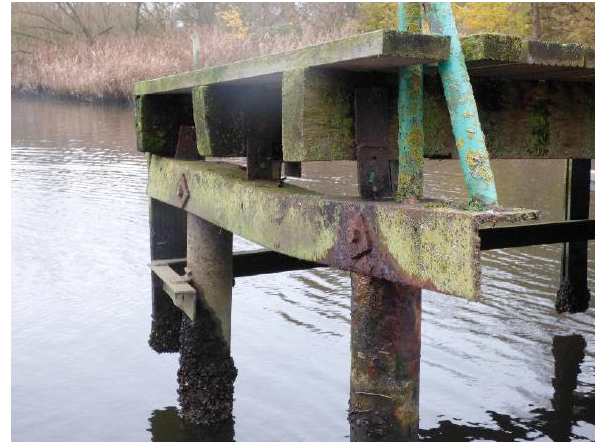
Abbildung 21: Leitwerk am Unterhaupt
