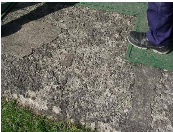
Abbildung 13: Betonoberfläche am Oberhaupt
