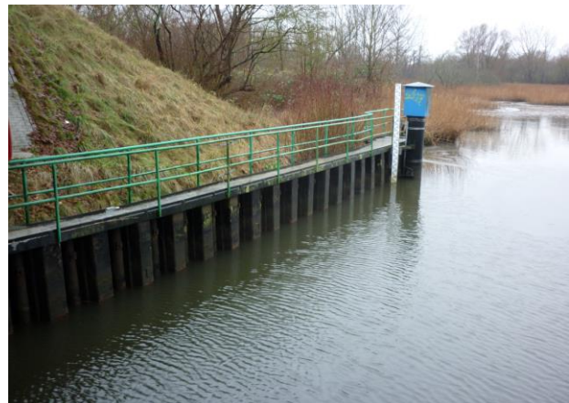
Abbildung 7: Leitwerke am Unterhaupt, Ansicht
