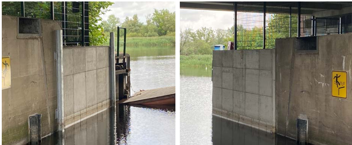
Abbildung 42: Sanierte Kammerwände Oberhaupt (Juli 2021)
