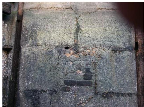
Abbildung 14: Mauergefüge am Oberhaupt
