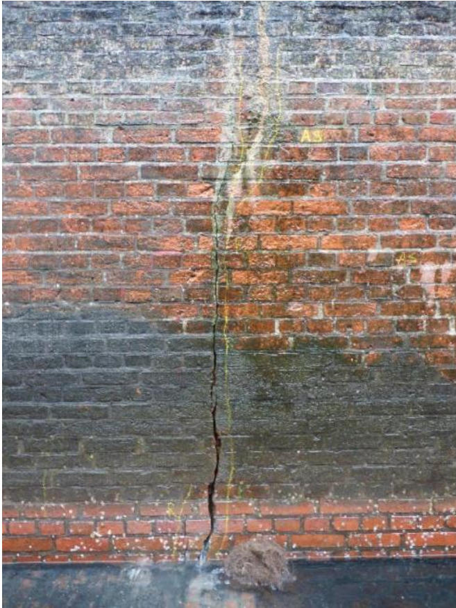
Abbildung 11: Wasserführender Vertikalriss
