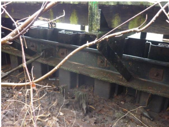
Abbildung 6: Leitwerke am Unterhaupt, Rückansicht
