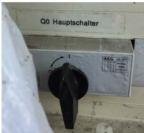
Abbildung 33: Hauptschalter Hausanschluss
