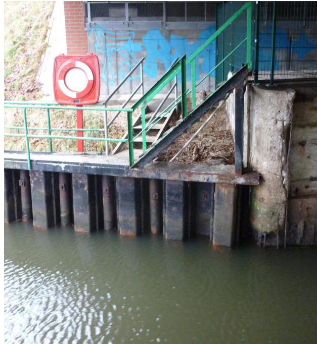
Abbildung 5: Unterhaupt - eingebaute Flügelwände
