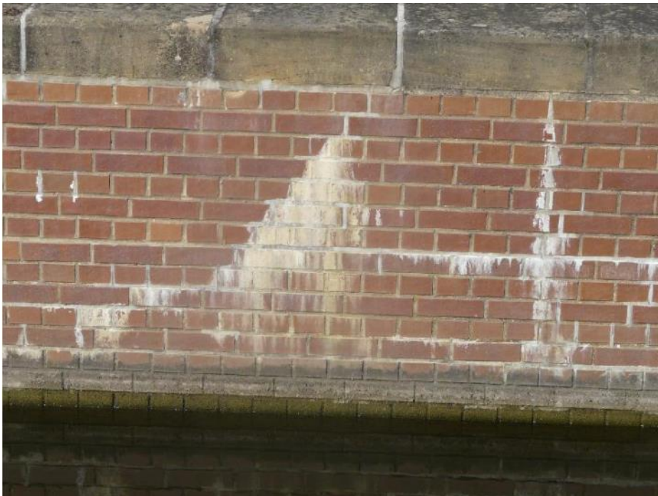
Abbildung 10: Aussinterungen an Kammerwänden
