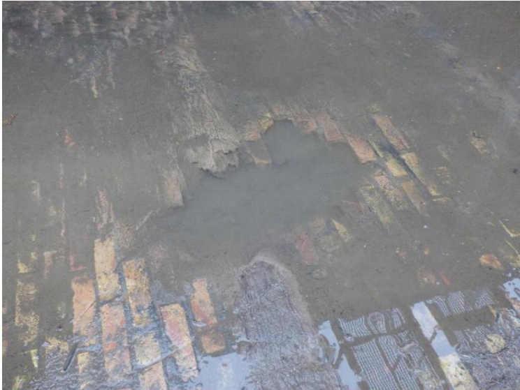
Abbildung 12: Fehlstelle Kammersohle
