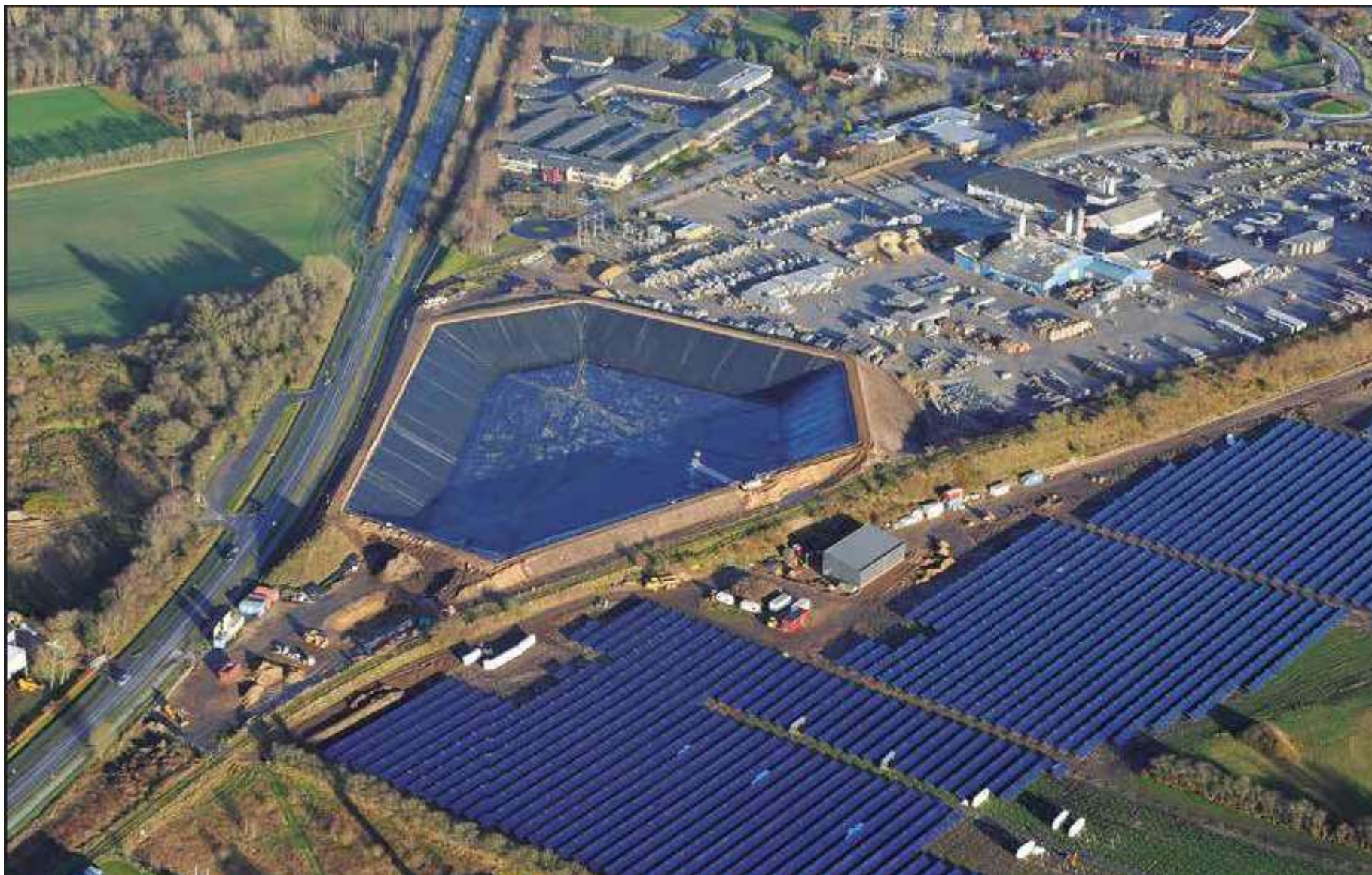
Erdbeckenspeicher mit 200.000 m 3 in Vojens / DK im Bau ca. 2013
