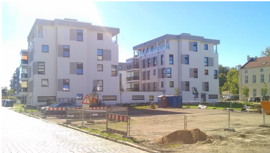
Derzeitige Baulücke an der Bleicherstraße mit Blick auf die südliche Wohnbebauung sowie die westliche Grünfläche mit angepflanzten Bäumen
