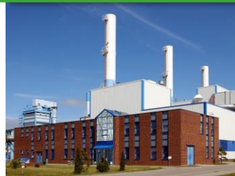
Erdgas Heizkraftwerk SWR
