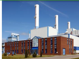
Erdgas Heizkraftwerk SWR
