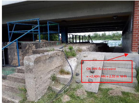
Abbildung 25: Bestand östl. Fluttorlinie i.R. Unterwasser, Foto: M. Kuhl
