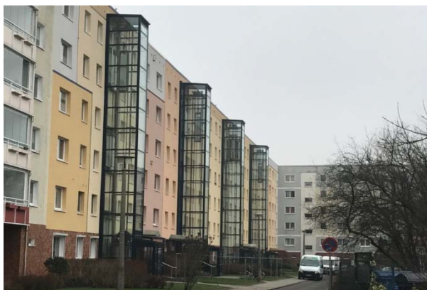
Gebäude mit nachgerüsteten außen- und innenliegenden Fahrstühlen
