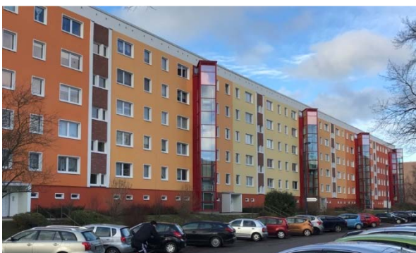
nachgerüstete außenliegende Fahrstühle
