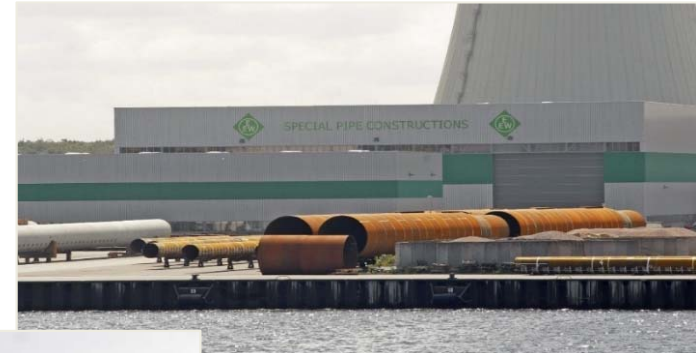
Großröhrenwerk von EEW
