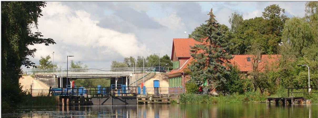
Abb. 13: Schleuse am Mühlendamm (vor dem Bau der Behelfsbrücke) (Quelle: EIGENE AUFNAHME, 2011)
