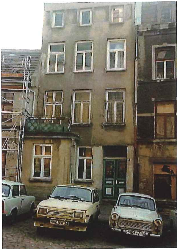
Am Schwibbogen 7 vor der Sanierung
