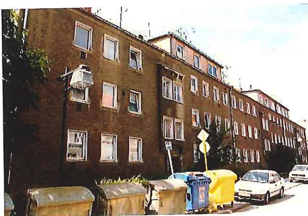
Altschmiedestraße 1-3 vor der Sanierung
