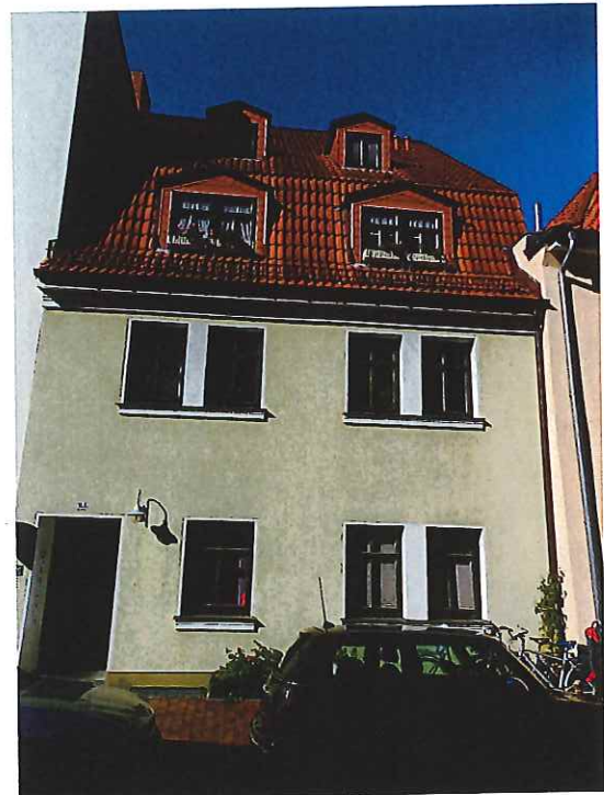
... Wollenweberstr.14a nach Sanierung
