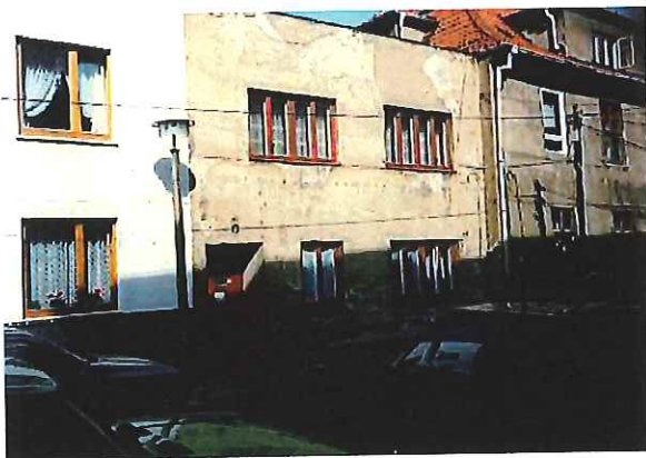
Wollenweberstraße 14a vor der Sanierung
