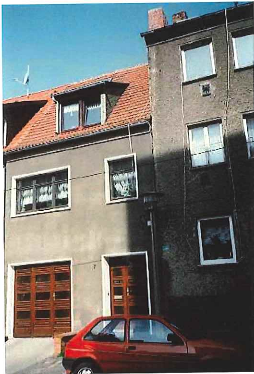
Wollenweberstraße 7 vor der Sanierung
