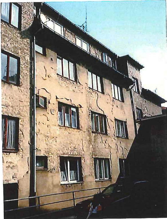
Molkenstraße 1 (Hofbereich) vor Sanierung
