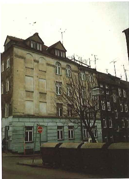
Am Wendländer Schilde 14 vor Sanierung
