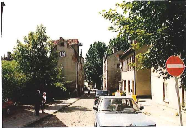
Bliesathsberg vor der Sanierung
