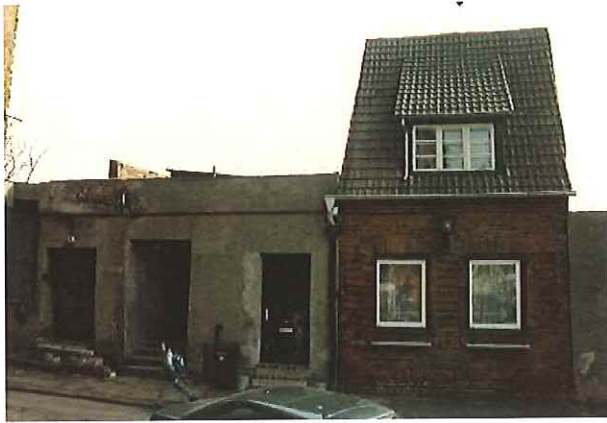
Am Schwibbogen 2, 3 vor der Sanierung
