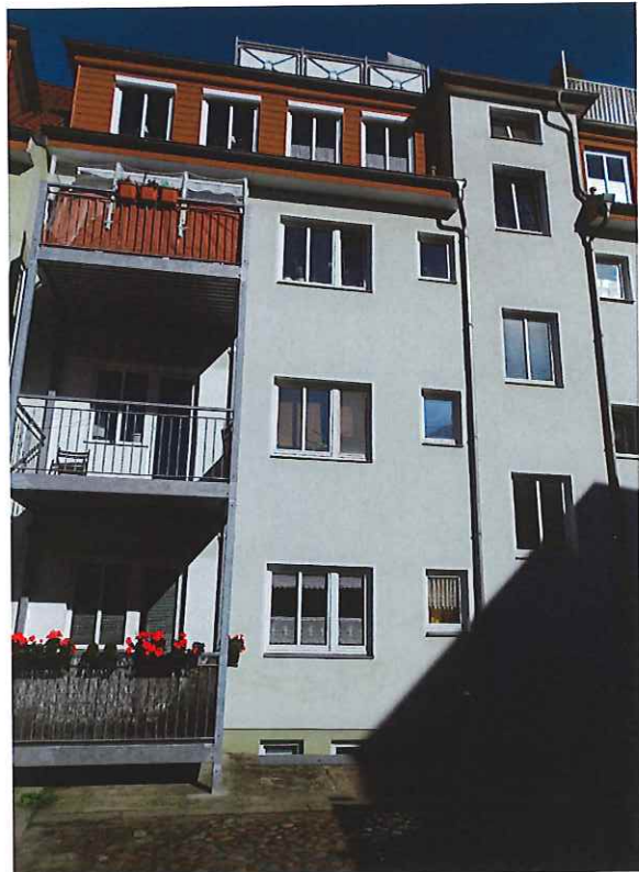
... Molkenstraße 2 nach Sanierung (Hofbereich)
