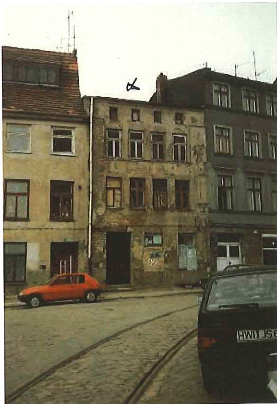
Am Wendländer Schilde 9 vor Sanierung
