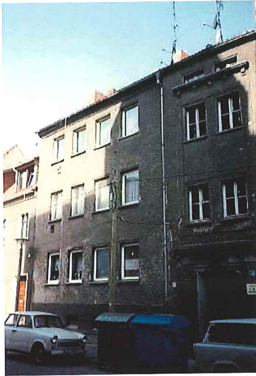
Wollenweberstraße 8 vor der Sanierung
