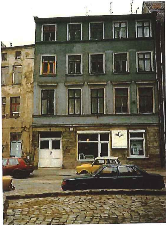
Am Wendländer Schilde 10 vor Sanierung
