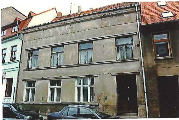
Altschmiedestr.26 vor der Sanierung
