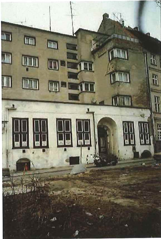
Am Wendländer Schilde 5-6 vor Sanierung
