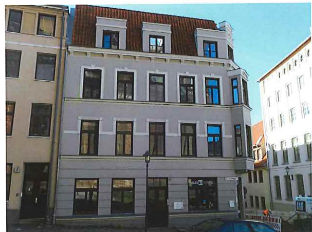
... am Schwibbogen 8 nach Sanierung
