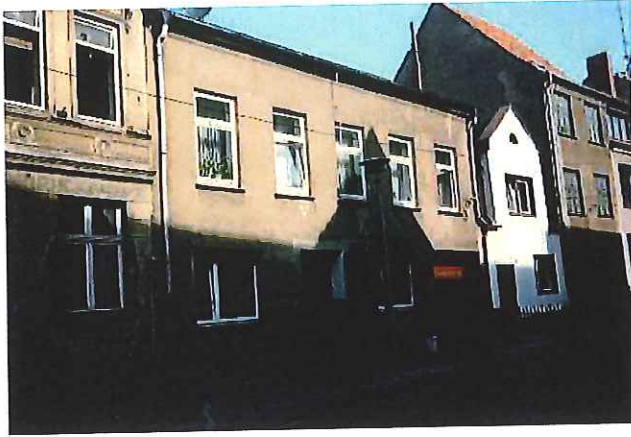
Wollenweberstraße 3 vor der Sanierung
