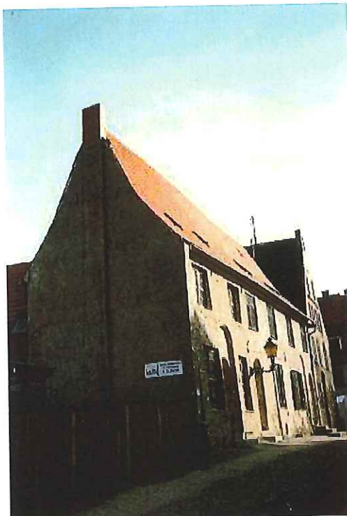
Bei der Nikolaikirche 3 – 5 vor Sanierung
