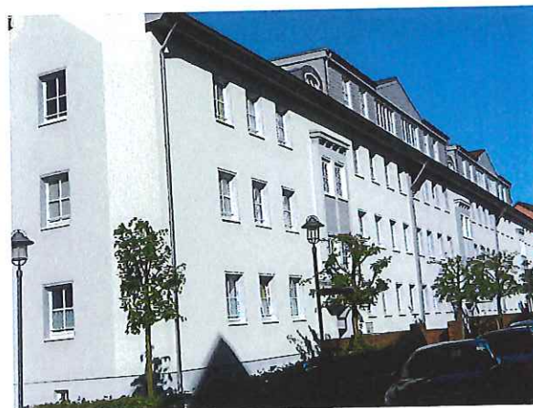
Altschmiedestraße 1-3 nach der Sanierung
