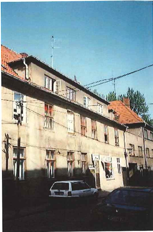
Wollenweberstraße 15 vor Sanierung
