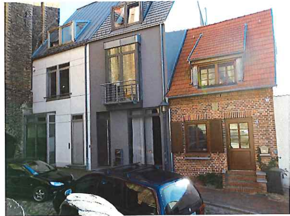
... Am Schwibbogen 2, 3 nach Sanierung
