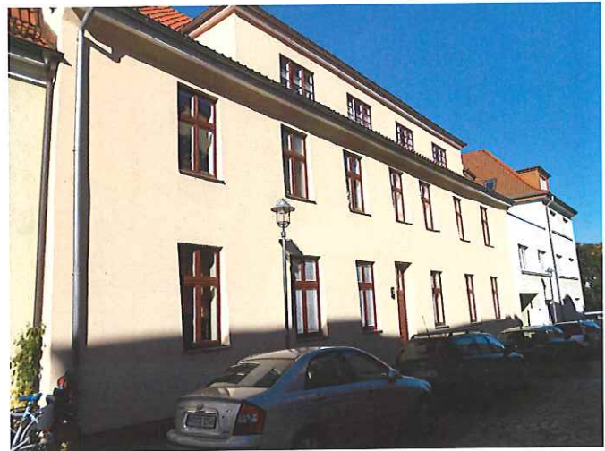
... Wollenweberstraße 15 nach Sanierung
