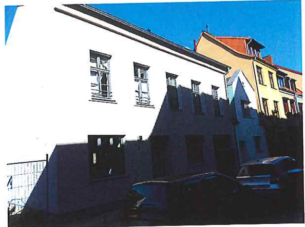
... Wollenweberstraße 3 nach Sanierung
