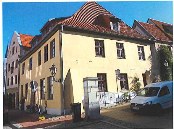
Altschmiedestr. 35/36 nach der Sanierung
