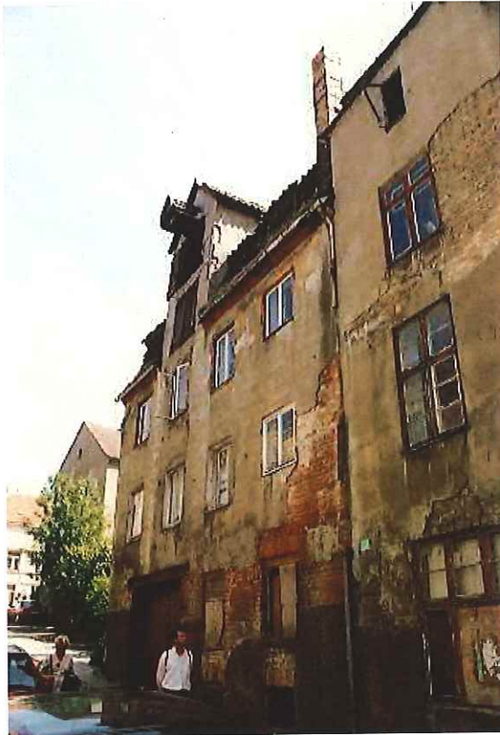
Wollenweberstraße 50 vor der Sanierung
