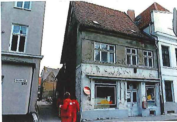
Altschmiedestr.32 vor der Sanierung
