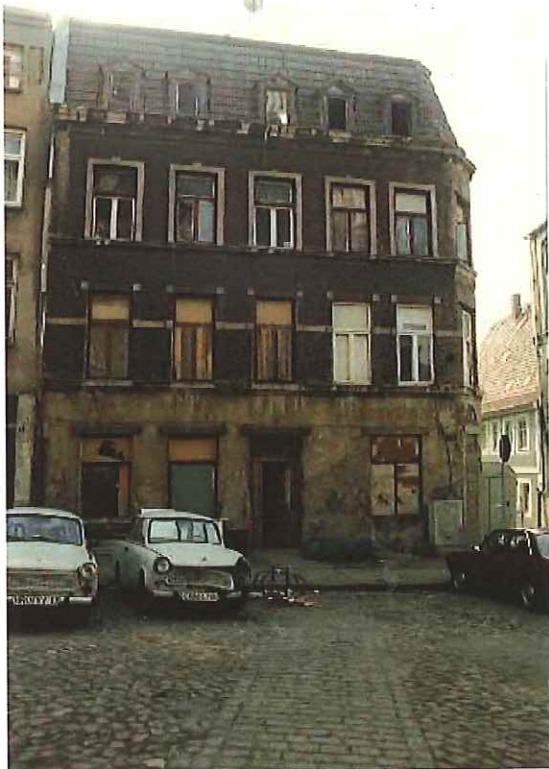
Am Schwibbogen 8 vor der Sanierung
