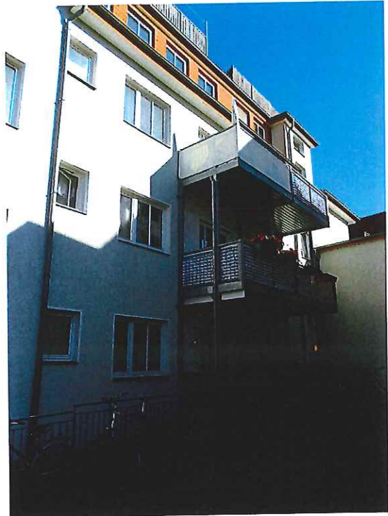
... Molkenstr.1 (Hofbereich nach Sanierung)
