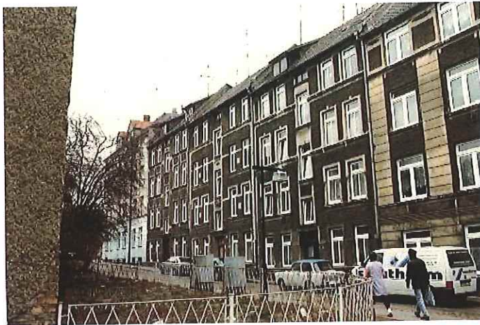
Brauergasse vor der Sanierung
