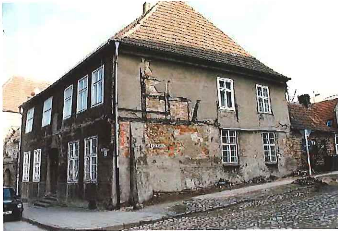
Altschmiedestr. 35/36 vor der Sanierung
