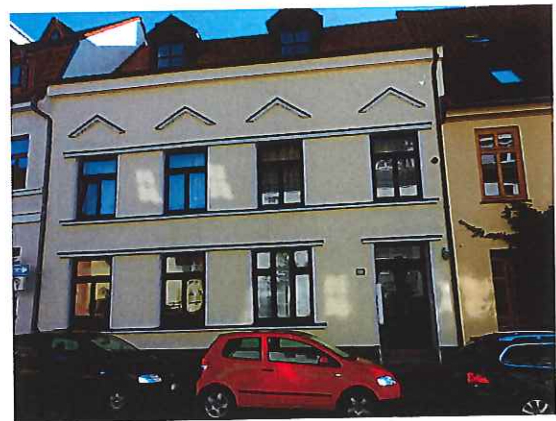
... nach der Sanierung
