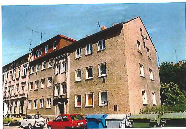
Wollenweberstraße 56 vor der Sanierung
