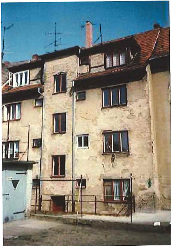
Molkenstr. 2 (Hofbereich) vor Sanierung
