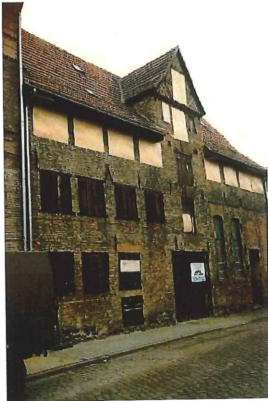
Wollenweberstraße 62 vor Sanierung
