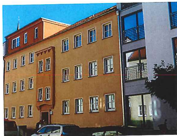
Wollenweberstraße 56 nach der Sanierung
