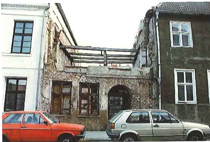
Altschmiedestr. 34 vor der Sanierung
